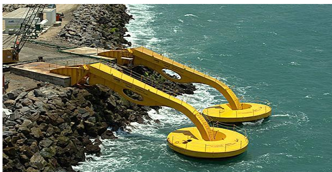
Figura 3. Dispositivo da COPPE/RJ em operação no porto de Pecém/CE.
