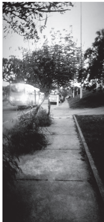
Figura 5: Pavimentação regular do passeio
