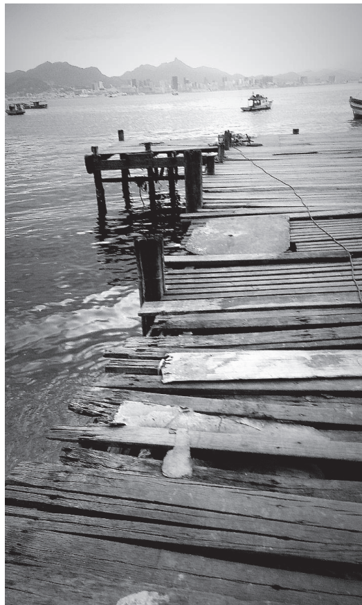
Figura 13: Estrutura do píer
