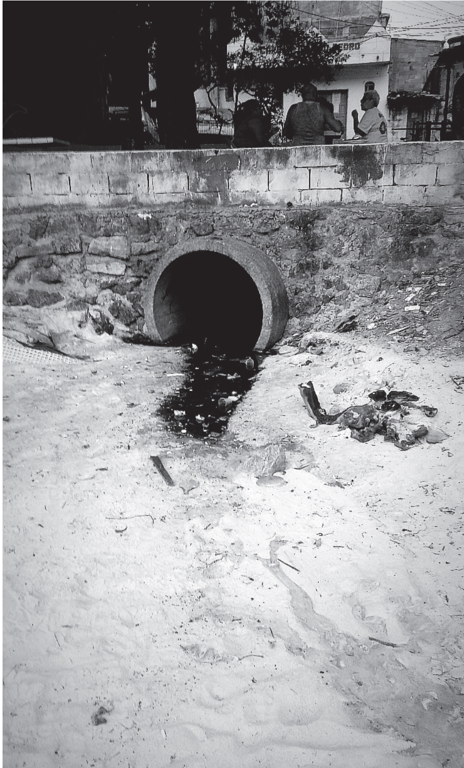
Figura 12: Detalhe saída do esgoto
