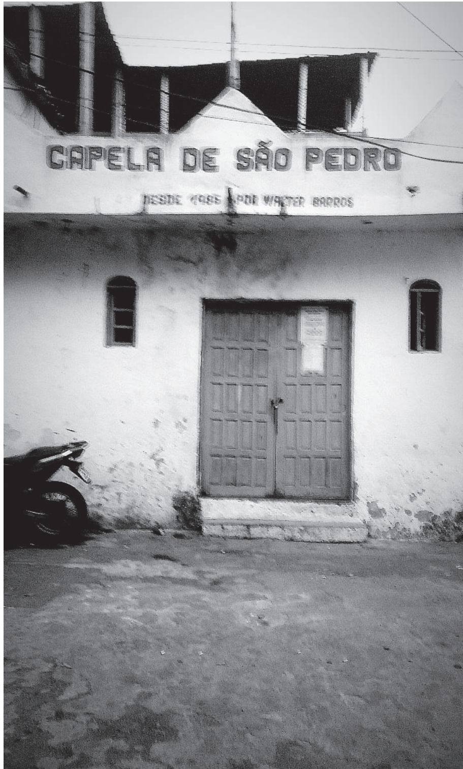
Figura 7: Fachada da Capela de São Pedro
