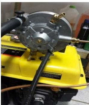
Figura 10. Válvula redutora e adaptação na alça de transporte do gerador
