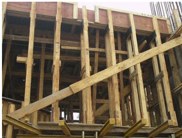
Figura 2 - Utilização no canteiro de obras
